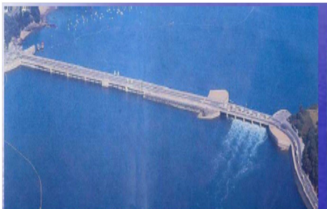
Figura 7. Aprovechamiento de la energía potencial de las mareas en el estuario del río Rance, Francia. Fuente: Manuel Lara Coira, La Energía del Mar.
