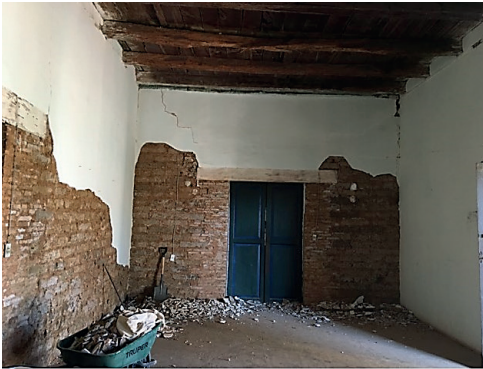
Figura 8. Liberación de aplanados o revoques.
