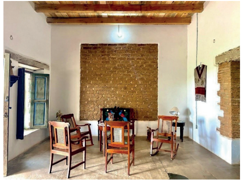
Figura 9. Consolidación muros y vigas tensoras.
