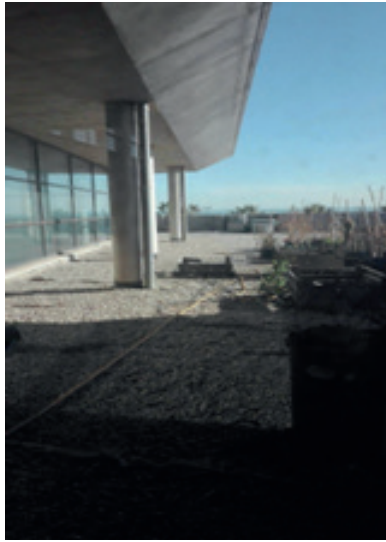
Imagen 2. Terrazas pisables con grava en la superficie. Fuente propia.
