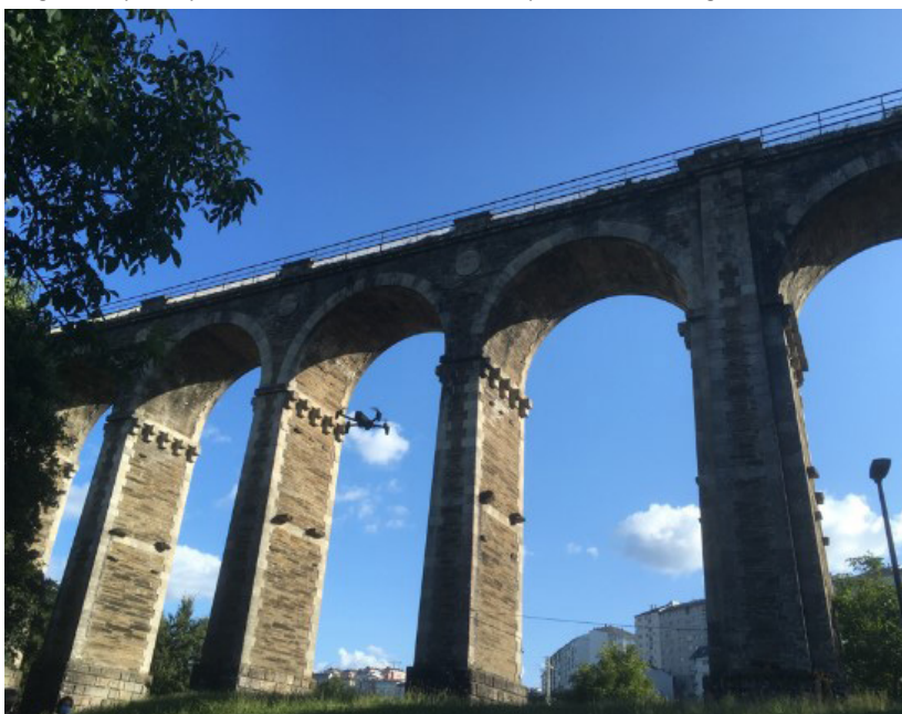
Figura 2: Drone cuadricóptero aproximándose para una inspección al Ponte da Chanca, viaducto ferroviario en la ciudad de Lugo, en España, que el 20 de diciembre de 2021 cumplió 150 años (fotografía del autor).
