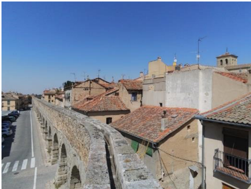
Figura 28: Imagen tomada con el dron cuadricóptero en el vuelo recogido en la Figura 27, donde se puede observar el caz por el que antiguamente circulaba el agua (fotografía del autor).
