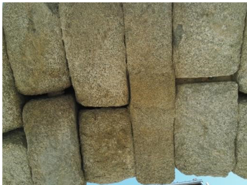
Figura 31: Imagen tomada con el dron cuadricóptero, que con mayor aproximación y detalle analiza el desplazamiento de sillares recogido en la Figura 30, donde se observa el rozamiento entre las dovelas (fotografía del autor).
