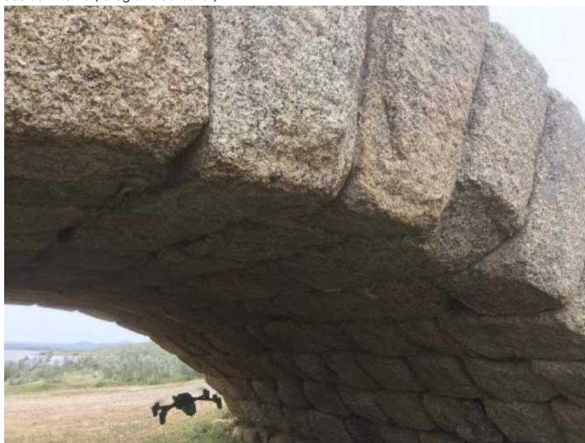
Figura 14: Drone cuadricóptero circulando por el interior del primer arco recogido en la Figura 13, para inspección del intradós del mismo (fotografía del autor).
