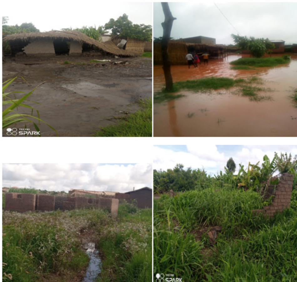
Foto 1: Construções nas áreas inundáveis.
