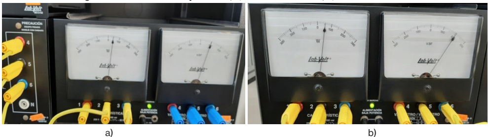
Figura 5. Medición de real y reactiva, a) al inicio de la línea, b) al final de la línea.
