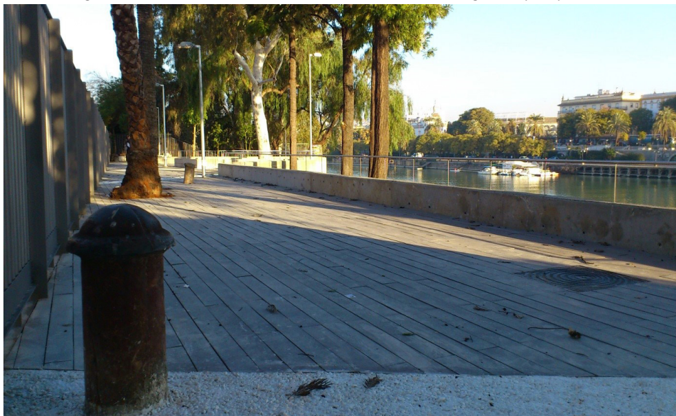
Figura 4. Nuevo muelle camaronero. Vista desde la calle Betis. Fotografía mrpr arquitectos.
