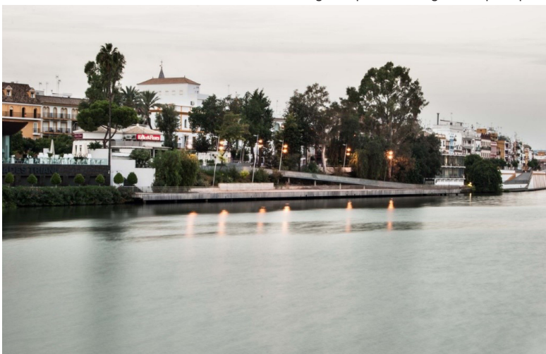
Figura 8. Nuevo muelle camaronero. Vista desde la margen izquierda. Fotografía mrpr arquitectos.
