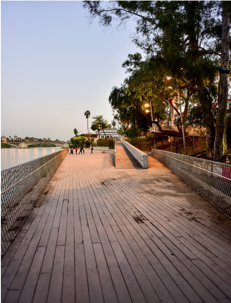
Figura 5. Nuevo muelle camaronero. Vista desde la plataforma inferior. Fotografía mrpr arquitectos.
