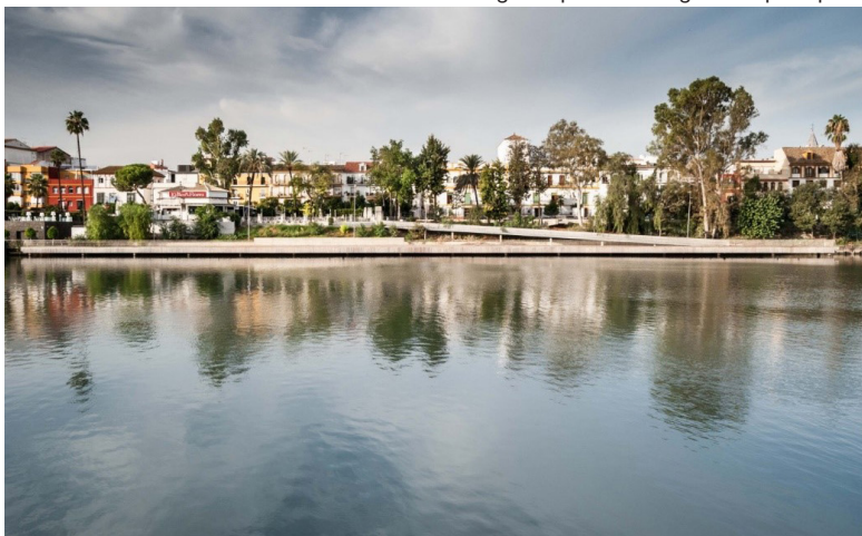
Figura 7. Nuevo muelle camaronero. Vista desde la margen izquierda. Fotografía mrpr arquitectos.
