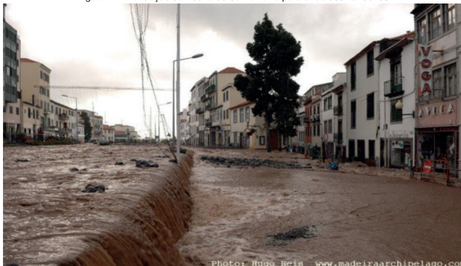
Figura 12 - Inundação da ribeira de Santa Luzia para a rua dos Tanoeiros.
