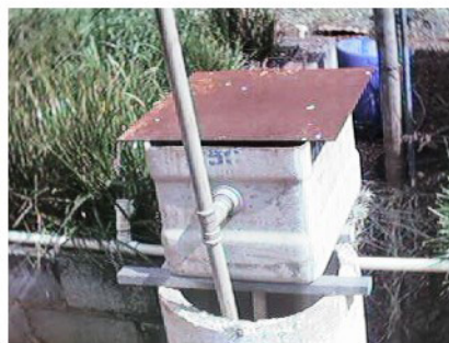
Figura 4 –Visão da caixa de distribuição e sistema de wetlands.
