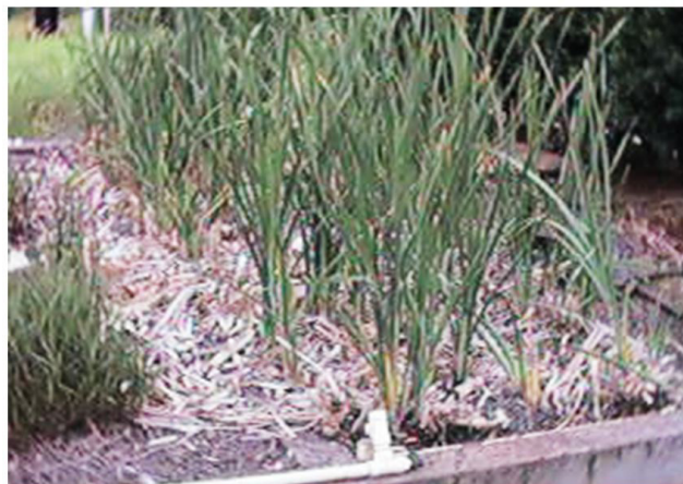
Figura 6 – Célula retangular (4x1m). Pode-se verificar a existência do material de suporte brita n.º2 juntamente da linha em PVC de distribuição.
