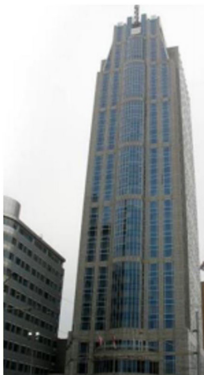
Figura 1 - Edifício Millenium Tower, Rotterdam, Holanda (BUBBLEDECK-UK, 2008).
