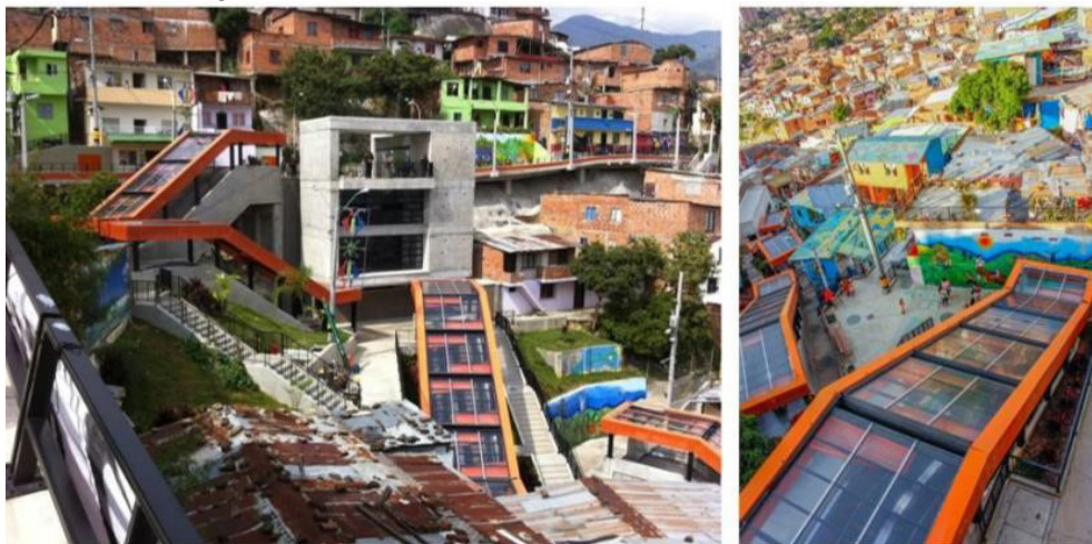
Fig. 8. Escaleras mecánicas en la Comuna 13 en Medellín, Colombia, 2012.
