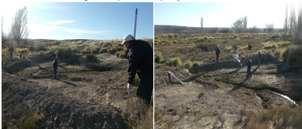
Figura 3. Terraplenado de la represa y vertiente natural.
