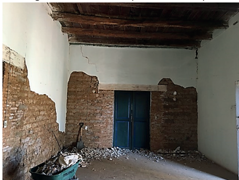
Figura 8. Liberación de aplanados o revoques.
