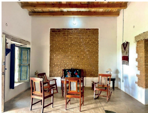
Figura 9. Consolidación muros y vigas tensoras.
