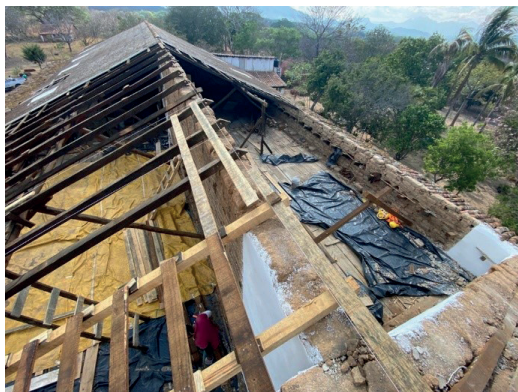
Figura 11. Sustitución de caballete y estructura de madera dañada por humedad y xilófagos.
