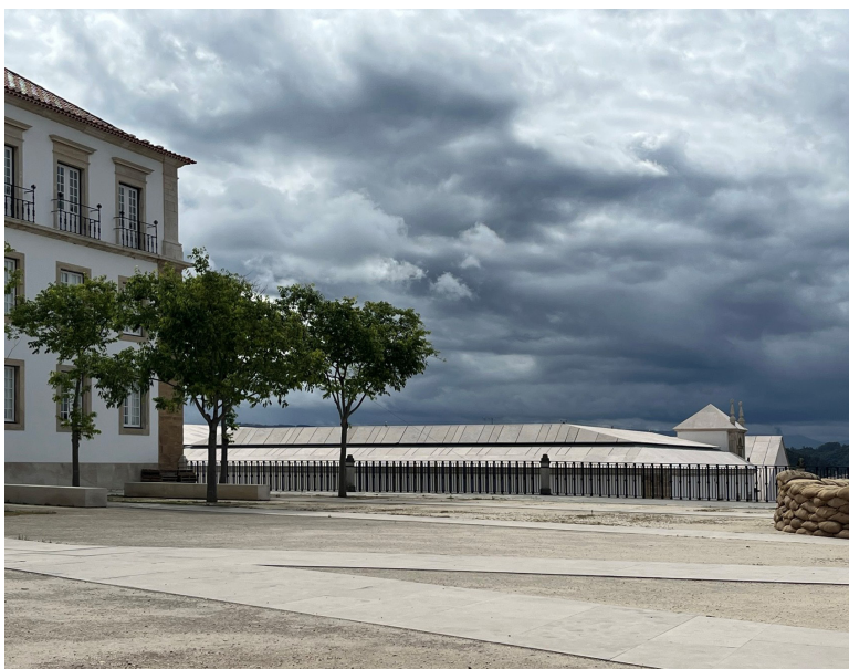
Fig. 5 Vista da cobertura do Colégio da Trindade a partir do pátio principal do Paço das Escolas. Fonte: Elaboração própria (2024).
