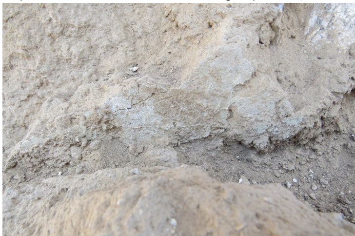
Figura 5. Detalle de pintura blanca en el muro de sostenimiento de la segunda plataforma (foto: Mariana Pineda, 2021).
