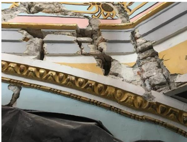
En primera instancia, se realizó una visita al templo con el fin de conocer con precisión el daño que había en sus elementos, en donde se percató que los muros de piedra, del lado de la fachada, presentaron grietas en la zona inferior, al borde de los contrafuertes.
