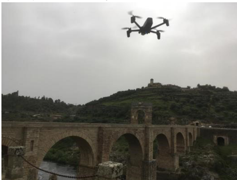
Figura 16: Dron cuadricóptero iniciando la maniobra de aproximación al Puente de Alcántara, desde aguas abajo del mismo, para la inspección del monumento (fotografía del autor).
