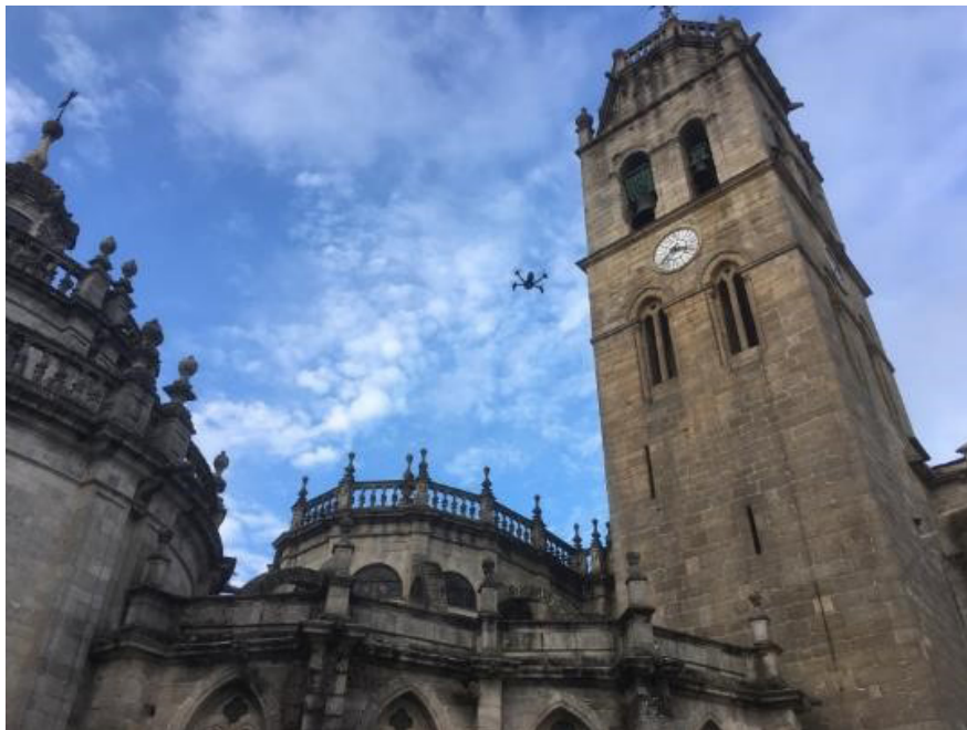
Figura 6: Drone cuadricóptero volando junto al ábside gótico y la Torre Vieja de la Catedral de Lugo, para un reconocimiento (fotografía del autor).
