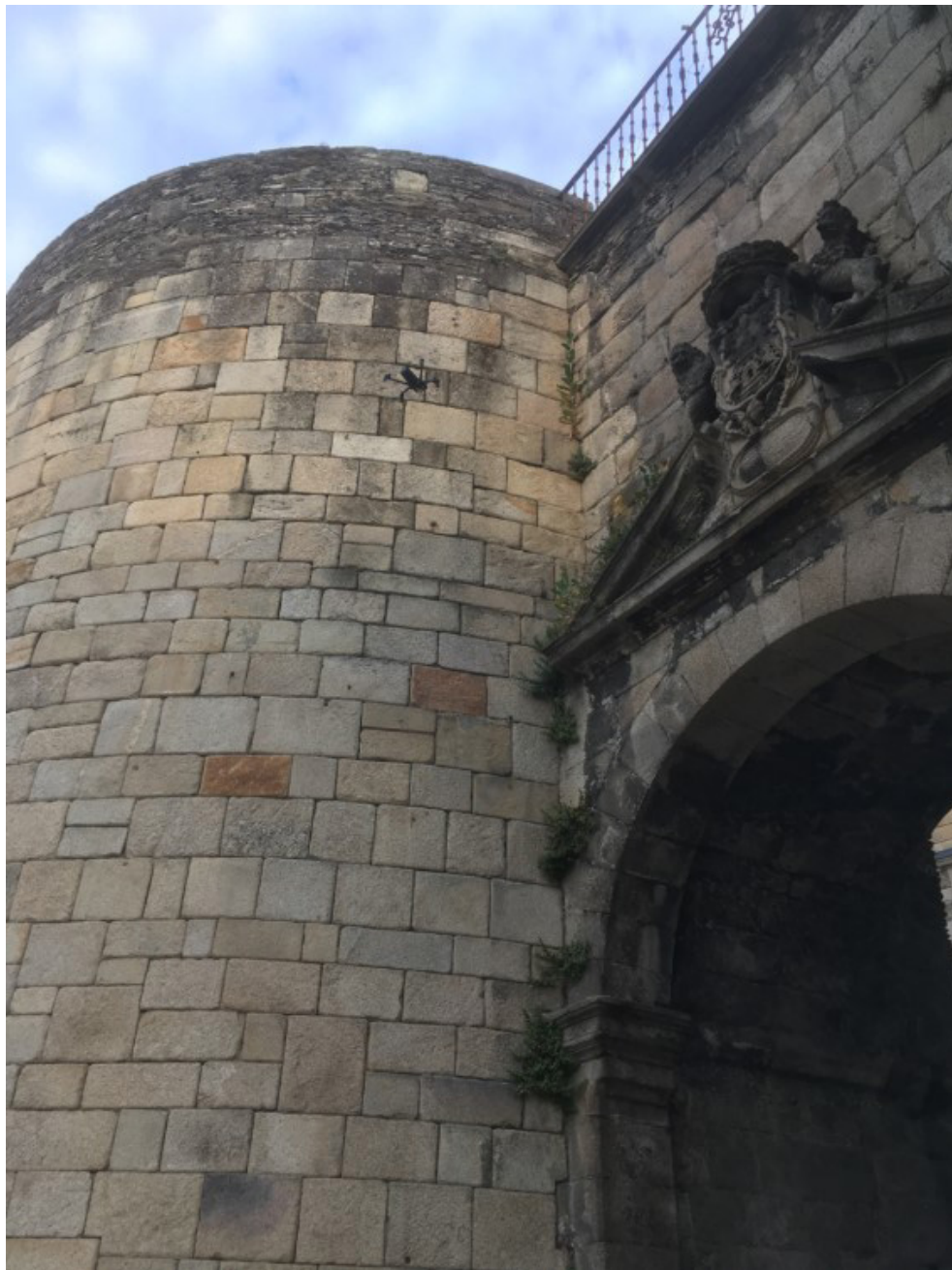
Figura 3: Vuelo de un dron cuadricóptero durante la inspección de un punto singular de la Muralla de Lugo, concretamente en la Porta de San Pedro ou Toledana (fotografía del autor).
