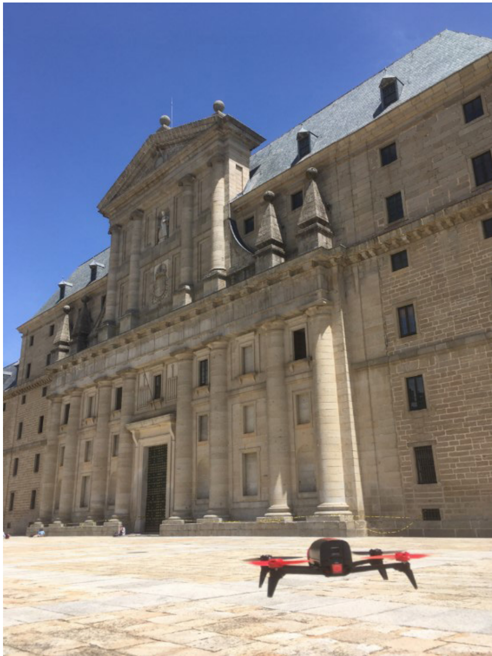
Figura 8: Drone cuadricóptero recién despegado, para iniciar una inspección, frente a la fachada principal del Real Monasterio de San Lorenzo de El Escorial (fotografía del autor).
