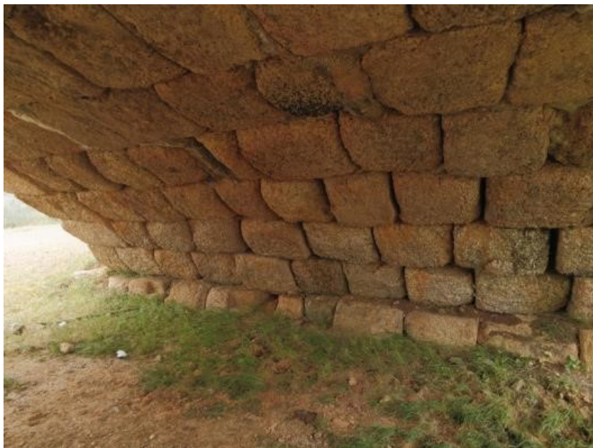
Figura 15: Imagen tomada por el dron durante su tránsito por el interior de la bóveda, recogido en la Figura 14, en la que se puede observar el estado de los sillares que conforman el intradós en el lado oeste de las ruinas del Puente (fotografía del autor).
