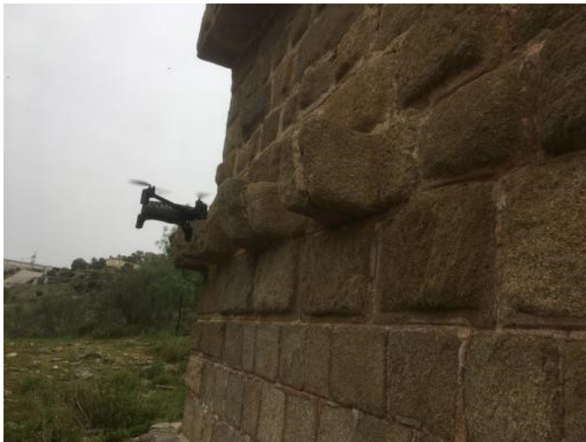
Figura 23: Drone cuadricóptero operando en el interior del segundo vano del Puente (contando desde el lado este, lado Alcántara) aproximándose a la primera pila para el reconocimiento de las piezas en voladizo para apeos (fotografía del autor).
