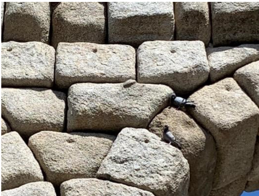
Figura 34: Imagen tomada con el dron cuadricóptero donde se aprecian puntos propicios para el posicionamiento y anidamiento de aves, particularmente palomas, y orificios en los sillares y dovelas que sirvieron para la colocación de los mismos durante la construcción (fotografía del autor).
