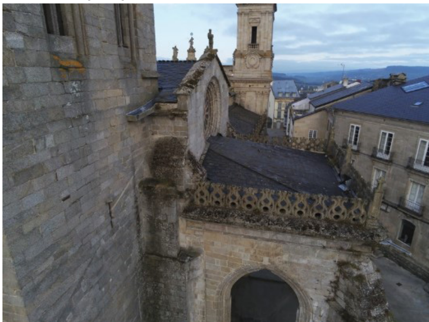
Figura 7: Imagen captada por el drone durante la inspección recogida en la Figura 6, donde se puede observar la presencia de materia orgánica y la acción sinérgica del agua de escorrentía en la cubierta del soportal de la entrada norte de la Catedral de Lugo (fotografía del autor).
