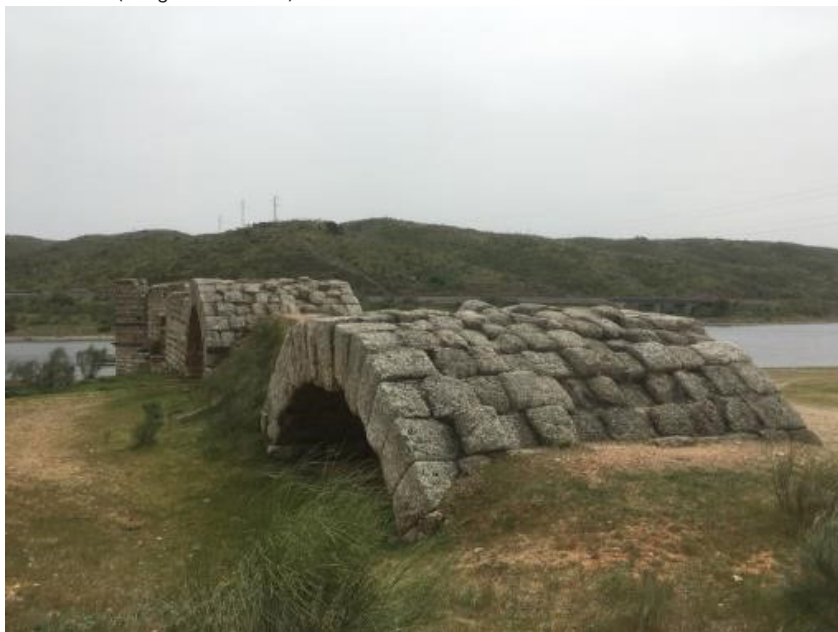
Figura 13: Vista de los primeros arcos del estribo occidental (arcos 1 y 2) aún conservados del Puente Romano de Alconétar: arcos rebajados en los que, especialmente el primero, la escasa flecha dificultaba el acceso de una persona a su interior (fotografía del autor).
