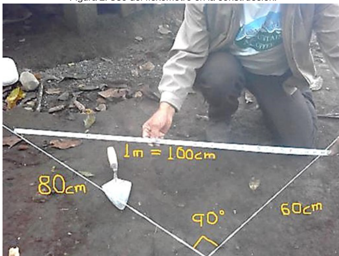
Figura 2: Uso del flexómetro en la construcción.
