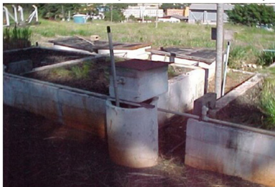
Figura 4 –Visão da caixa de distribuição e sistema de wetlands.
