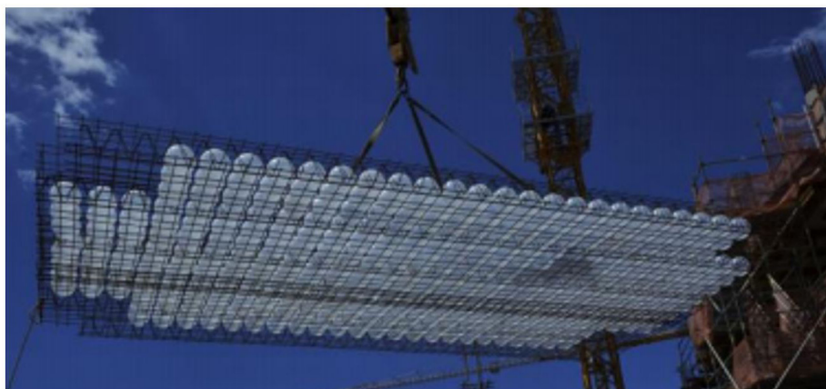
Figura 3 - Módulo de laje Bubbledeck (BUBBLEDECK BRASIL, 2019).
