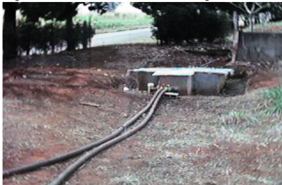
Figura 3 – Vista da caixa de areia com as mangueiras coletoras.
